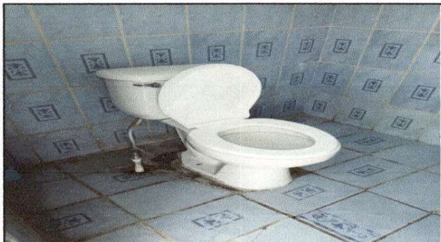
Foto 4: Finalización de sustitución de sanitarios
