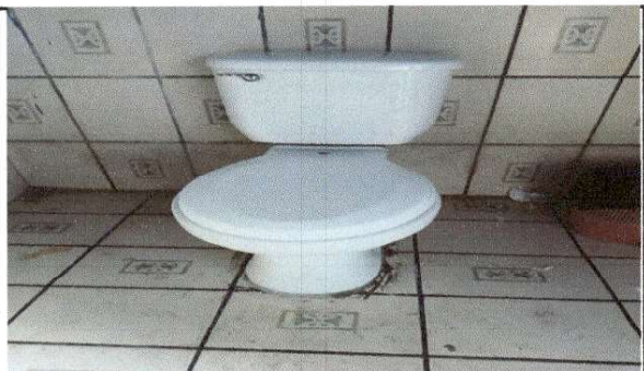
Foto 3: Finalización de sustitución de sanitarios
