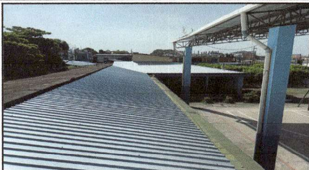
Foto 2: Finalización de sustitución de láminas por láminas troqueladas, calibre 26
