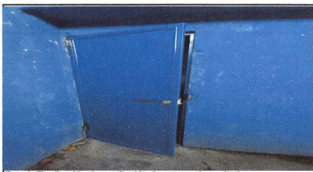
Foto 6: Finalización de sustitución de puertas de sanitarios
