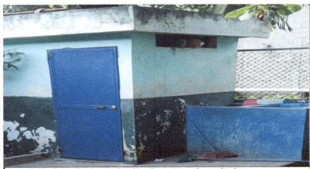
Foto 5: Finalización de sustitución de puertas de sanitarios
