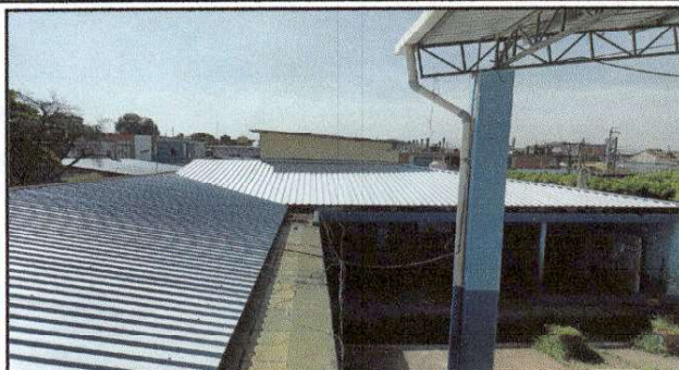
Foto 1: Finalización de sustitución de láminas por láminas troqueladas, calibre 26
